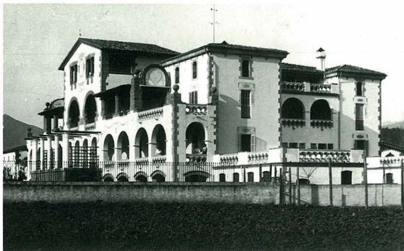
La Riba va ser reformada al final del primer decenni del segle XX d'acord amb el projecte de Rafael Masó. La fotografia mostra la casa un cop acabades les obres.
