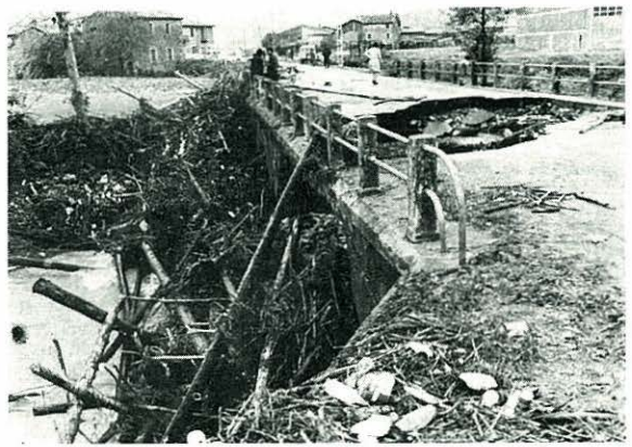
L'aiguat del mes d'octubre de 1977 causà força danys. Fotografia del pont de Llocalou, al bell mig del qual les aigües desbordades obriren un gran forat.
