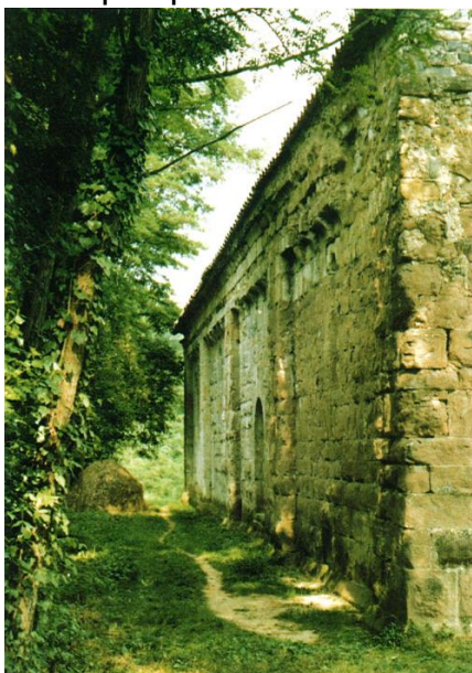
Vista exterior del mur de tramuntana. Cal notar-hi la manera com ha estat decorat. E. PABLO
